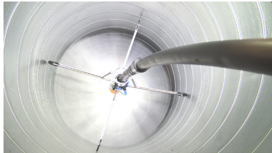
O dispositivo de centralização fixa a escova no centro da conduta.
